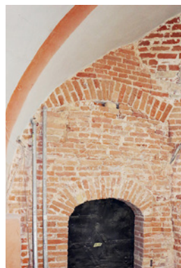
△ Svina torņa Z puses velves pieres augšdaļa. Labi redzama atšķirība starp 16. gadsimta (?) ķieģeļu mūrējumu torņa sienā un vēlākā izlauzuma mūrējumu ap durvju ailu. Foto: Jānis Ciglis
