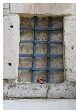
△ Svina torņa 1. stāva telpas R puses lodziņš no ārpuses. Dolomīti ar režģu iestiprinājuma vietām liecina, ka tā apdarē izmantots nopostītās pils būvmateriāls. Foto: Jānis Ciglis
