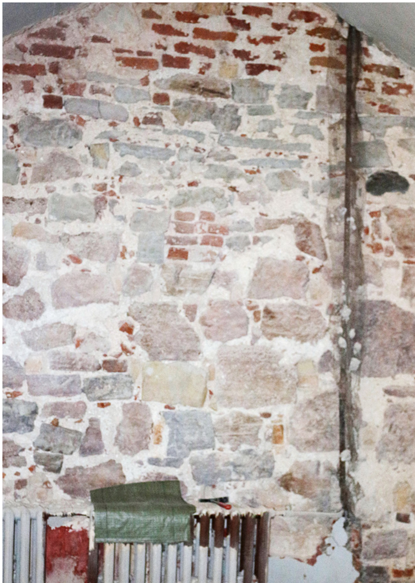
△ Svina torņa 1. stāva telpas D puses mūrējums, kas skaidri pierāda, ka logs tur nav bijis. Foto: Jānis Ciglis
