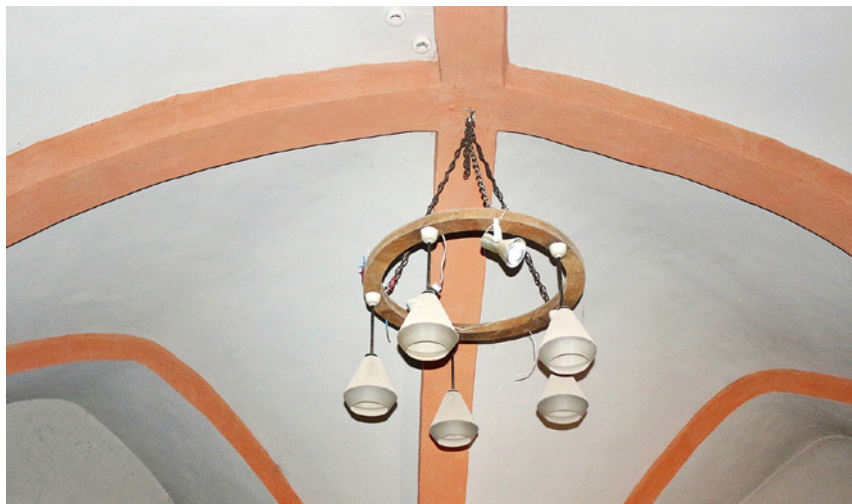
△ Svina torņa 1. stāva telpas krusta velves ar 1970. gadu beigu lukturi. Foto: Jānis Ciglis
