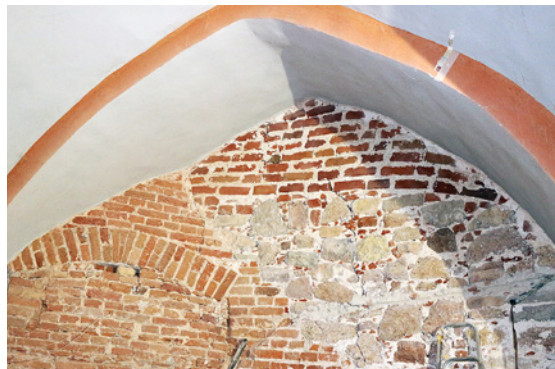
△ Svina torņa Z puses velves pieres augšdaļa. Labi redzama atšķirība starp 16. gadsimta (?) ķieģeļu mūrējumu torņa sienā un vēlākā izlauzuma mūrējumu ap durvju ailu. Foto: Jānis Ciglis
