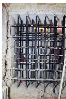
△ Durvjaila uz Svina torni, redzams durvju viras kāsis, kā arī bīdāmā balķa nišas (otrā durvju ēnā). Labi redzams durvjailas un pārseguma mucas velvītes mūrējums. Flīžu grīda no 1970. gadu beigām. Foto: Jānis Ciglis
